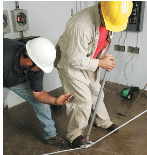
Рис. 1.11. Гибка трубы с помощью трубогиба
