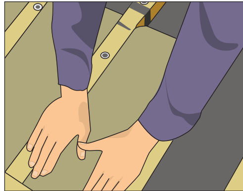
Рис. 12.14. Заполняем пространство между лагами теплоизоляционным материалом
