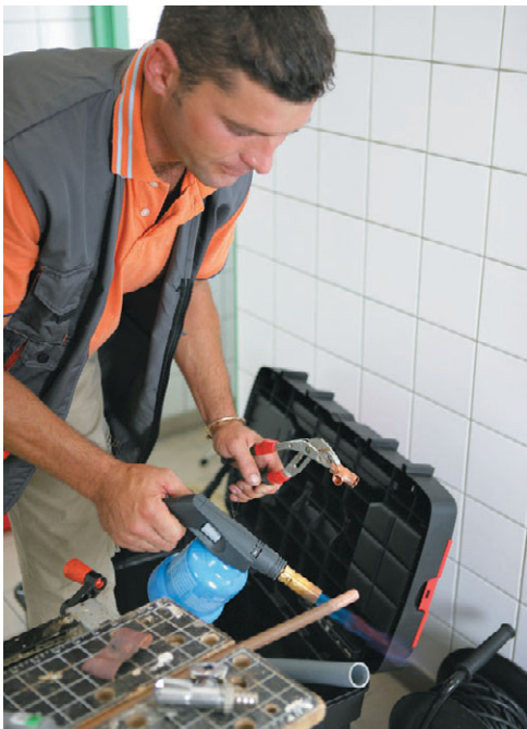
Рис. 4.54. Разогреваем трубу
