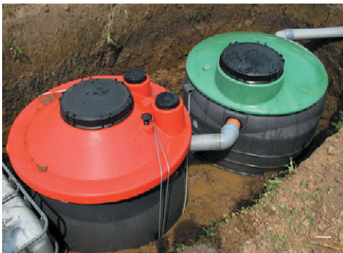
Рис. 8.25. Септик заводского производства из полиэтилена
