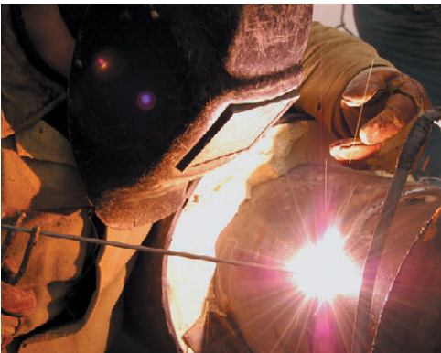
Рис. 4.50. Выполнение сварочных работ квалифицированным специалистом
