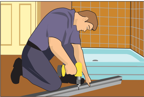
Рис. 10.217. Сверлим отверстия в профилях для крепления
