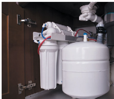
Рис. 7.7. Система фильтрации воды в доме
