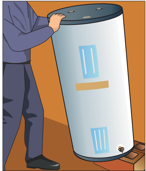
Рис. 10.283. Устанавливаем водонагреватель большого размера на смонтированную напольную подставку
