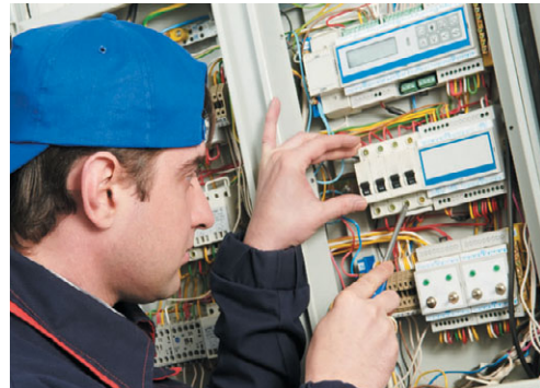
Рис. 10.305. Электрик подключает прибор к предохранительному автомату
