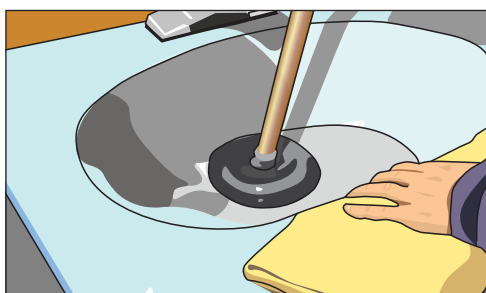
Рис. 11.10. Прижимаем вантуз к сливному отверстию раковины
