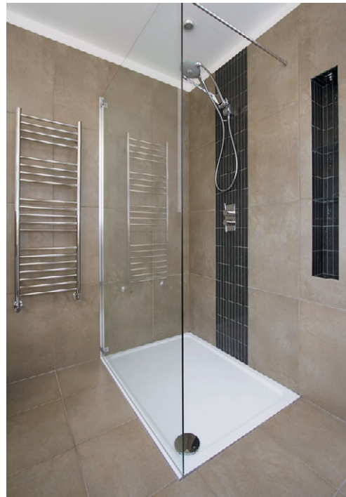
Рис. 10.209. Душевой угол — самый простой вариант душевой кабины
