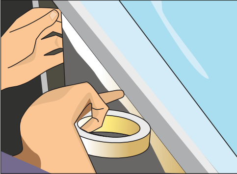
Рис. 11.105. Подготавливаем ванну к нанесению акрила (клеим двусторонний скотч по периметру)
