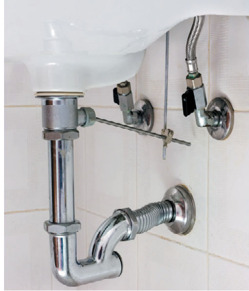
Рис. 10.10. Так выглядит смонтированный сифон
