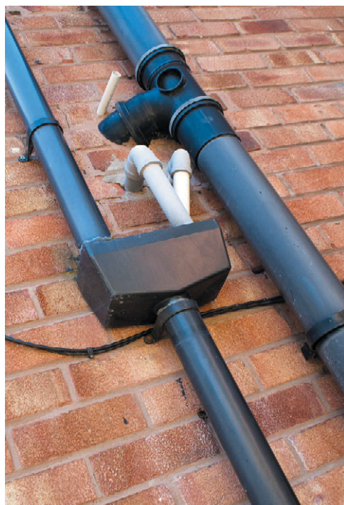
Рис. 5.4. Проложенные трубы с заделанными вокруг них пустотами
