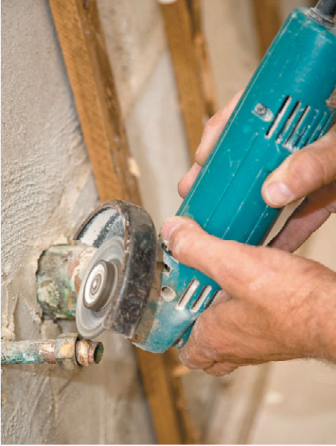
Рис. 1.15. Резка трубы с помощью болгарки
