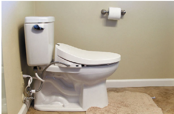
Рис. 10.155. Электронная крышка-биде для унитаза (слева), установленная на унитаз (справа)
