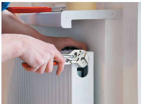
Рис. 3.3. Монтаж системы отопления
