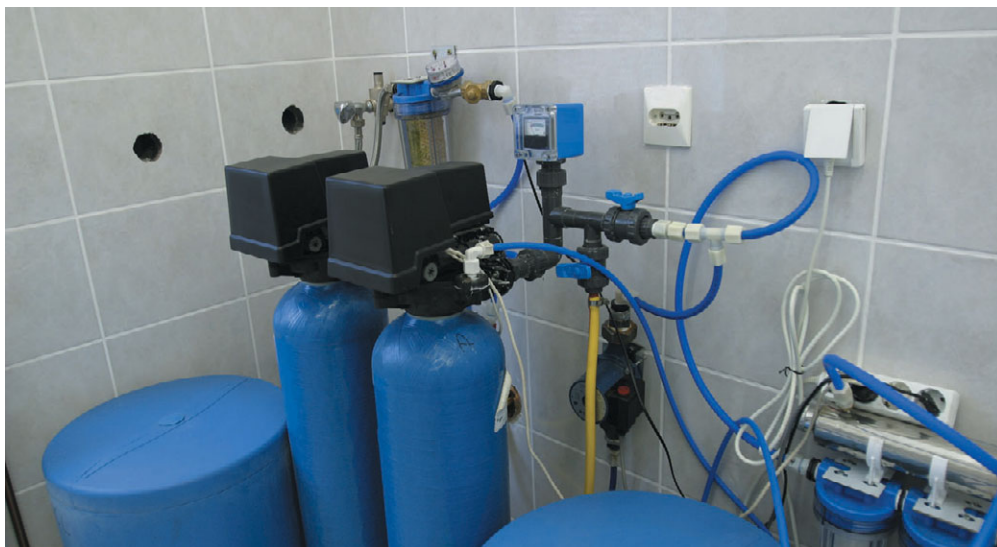
Рис. 7.1. Система многоступенчатой очистки воды
