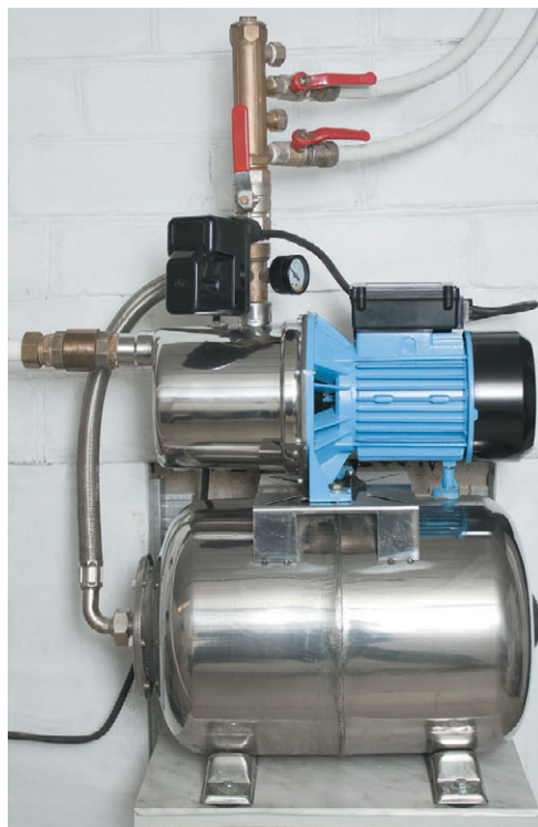
Рис. 12.20. Автоматический насос для радиаторного отопления
