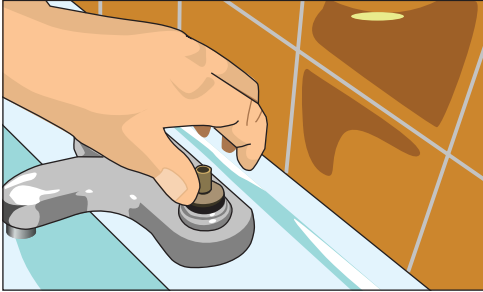
Рис. 11.40. Ввинчиваем новую буксу с новой прокладкой
