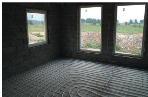
Рис. 12.2. Устройство теплого пола в собственном доме
