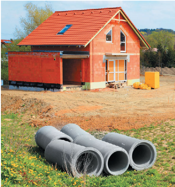
Рис. 3.10. Подключение дома к системе централизованного водоснабжения — процесс трудоемкий
