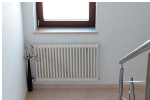
Рис. 12.42. Радиаторы располагают под окном
