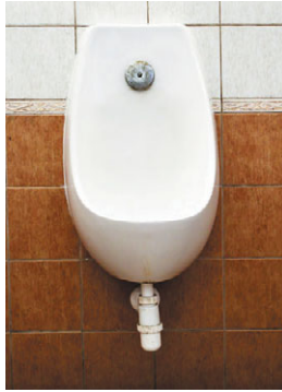
Рис. 9.124. Модель настенного писсуара с наружным пластиковым сифоном
