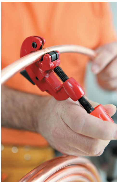
Рис. 4.47. Резка медных труб роликовым труборезом
