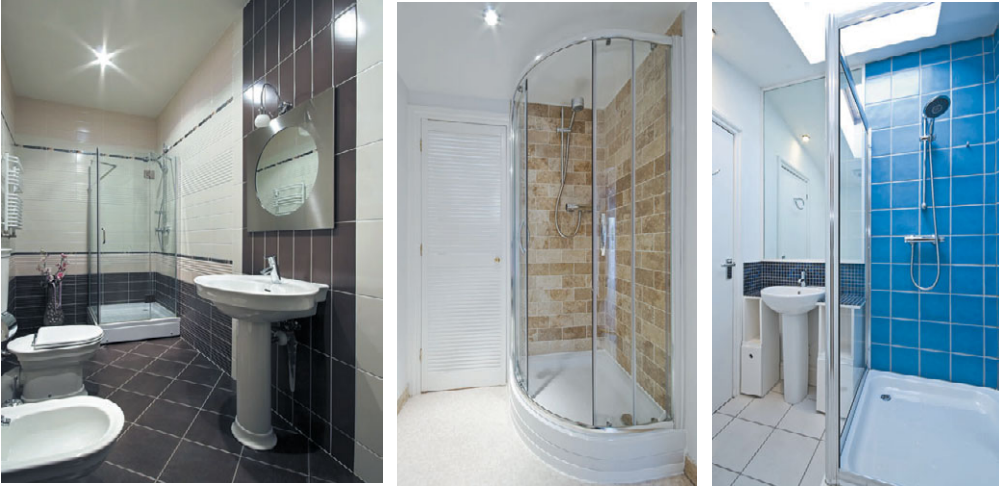
Рис. 10.208. Современные душевые кабины в интерьере ванной комнаты
