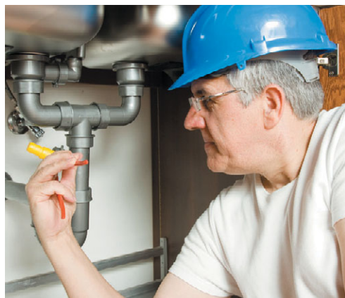
Рис. 11.1. Сантехнические приборы время от времени требуют ремонта
