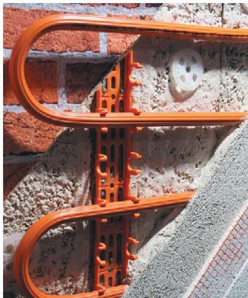
Рис. 12.19. Укладка гибких труб «змейкой» и последующая отделка стен
