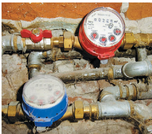
Рис. 6.1. Счетчики горячего и холодного водоснабжения
