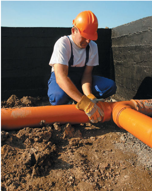
Рис. 8.2. Монтаж внутридомовых канализационных труб
