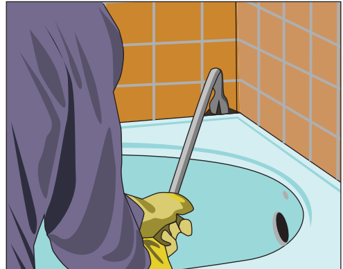
Рис. 10.161. Освобождаем стенки ванны от кафеля
