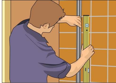
Рис. 10.219. Проверяем крепление профилей с помощью уровня
