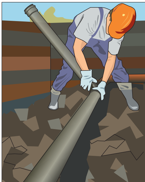
Рис. 8.37. Сборка труб в небольшие звенья по 3–4 штуки
