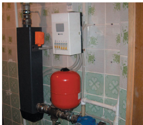
Рис. 12.23. Электрокотел «Сатурн» в системе отопления
