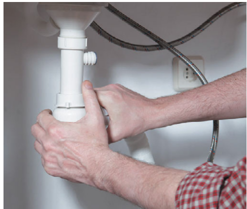
Рис. 10.78. Соединяем сифон со сливной трубой
