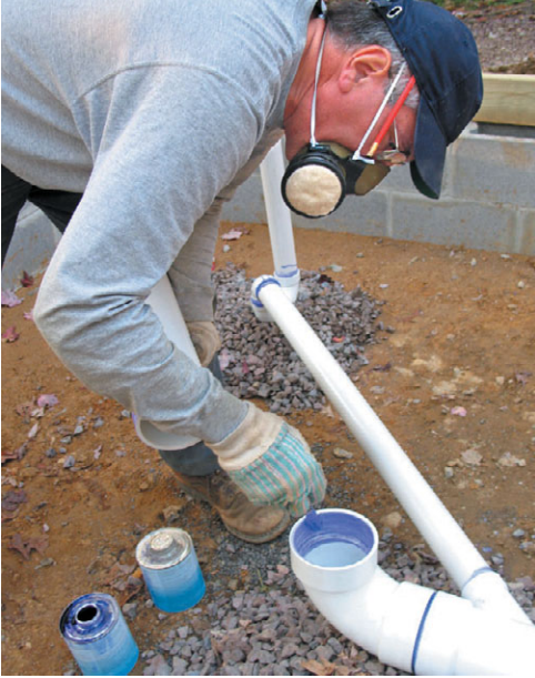
Рис. 4.64. Склеивание труб пластикового водопровода:
