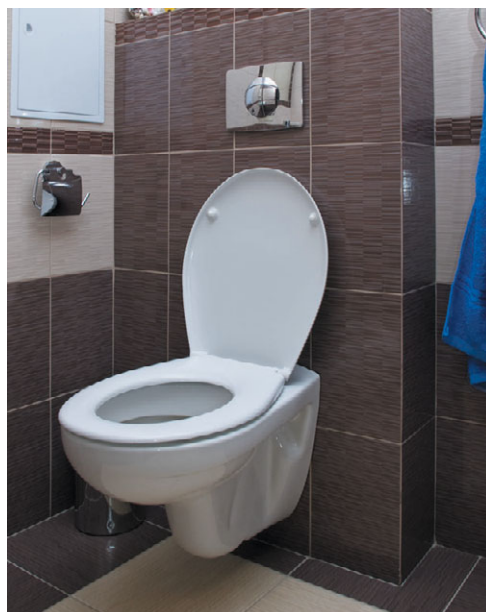
Рис. 10.122. На стене от бачка остается лишь декоративная клавиша для смыва воды
