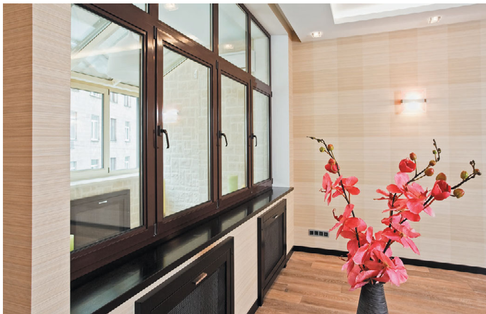
Рис. 12.49. Наличие экрана на радиаторе влияет на теплопроводность
