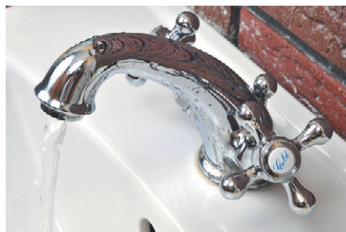
Рис. 10.12. Двухвентильный смеситель
