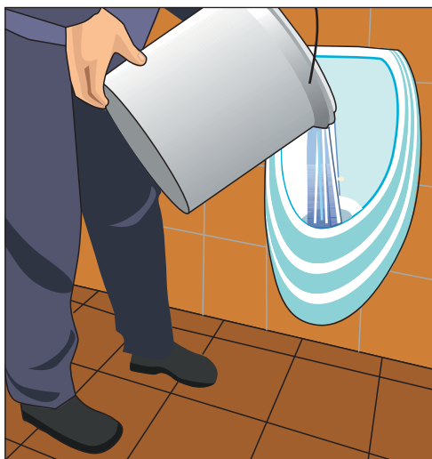
Рис. 10.138. Проверяем правильность монтажа писсуара: выливаем в него большое ведро воды и производим осмотр, нет ли течи
