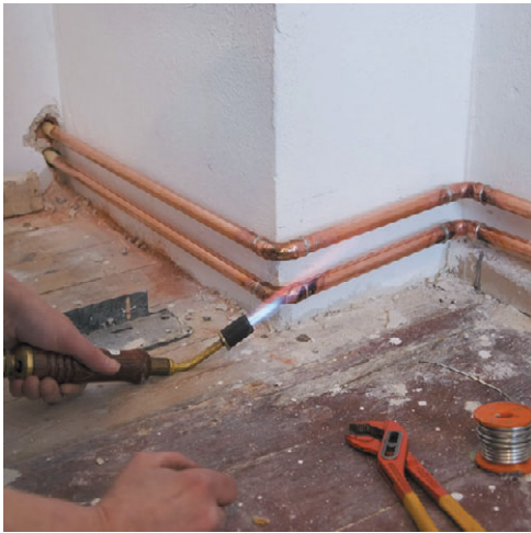
Рис. 4.2. Монтаж водопроводной сети в доме
