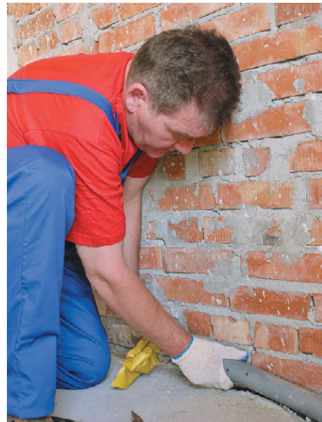
Рис. 8.22. Проверка стыков труб на герметичность
