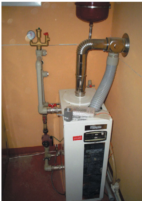
Рис. 12.28. Дизельный котел Saturn
