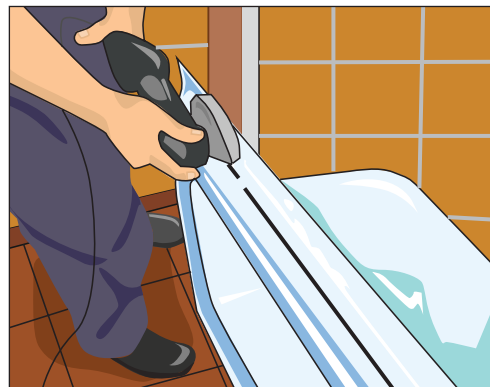
Рис. 11.92. Подрезаем борта вкладыша
