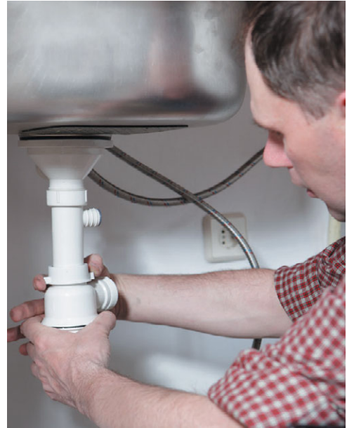
Рис. 10.77. Плотно прижав стакан к трубе, закручиваем гайку
