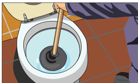
Рис. 11.13. Вставляем вантуз в отверстие унитаза и прокачиваем воздух вверх-вниз
