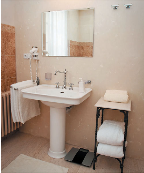
Рис. 10.62. Умывальники на классических пьедесталах
