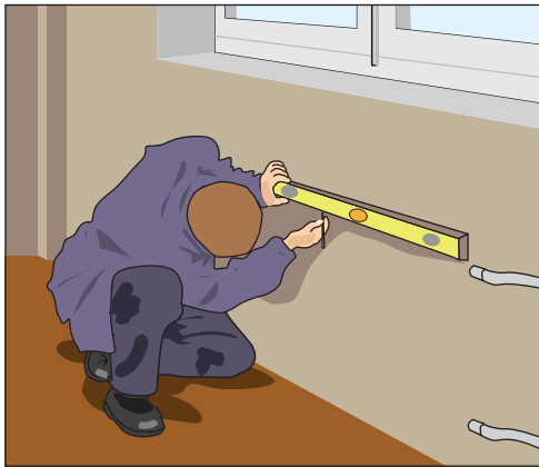
Рис. 12.54. Проводим горизонтальную линию крепления радиатора
